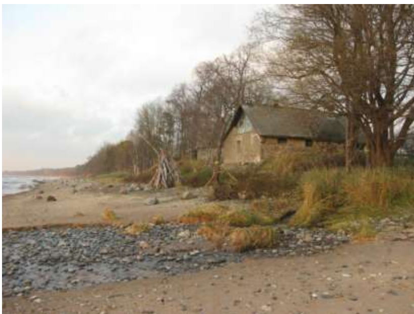
9.attēls. Skats uz „Vectimmāju” mājām, kas krasta erozijas procesu ietekmē jau tieši robežojas ar pludmali. Foto M.Kalvāne, 2012
