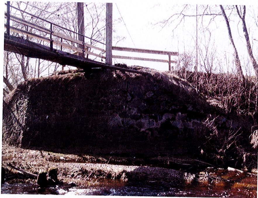
Skats uz gala balstu uz ass 2-2. Nelieli mūra izšuvējuma bojājumi.
