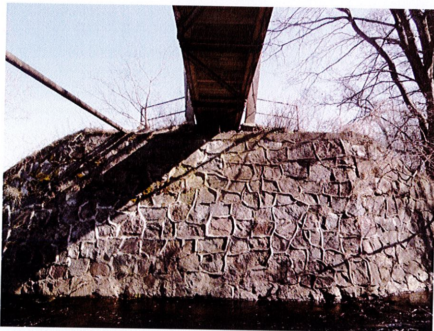
Skats uz gala balstu uz ass 1-1. Nelieli mūra izšuvējuma bojājumi.
