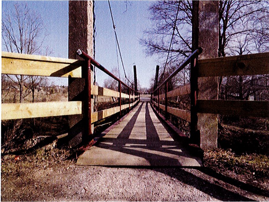
Skats uz gājēju tiltu no Zvejniekiema vidusskolas puses. Tilta margu nobeigumi veidoti neatbilstoši-nobeigumi nepieciešami noapaļoti, lai nav iespējams „uzdurties”.
