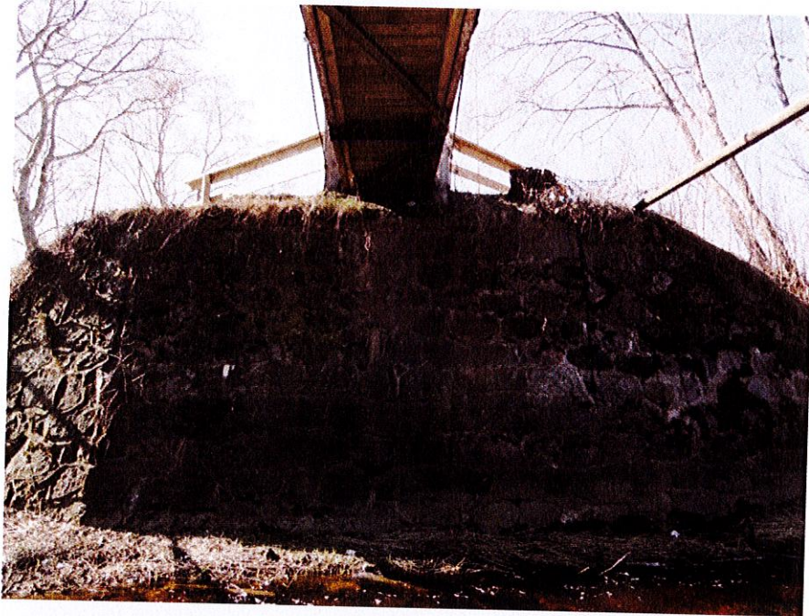
Skats uz gala balstu uz ass 2-2. Nelieli mūra izšuvojuma bojājumi.
