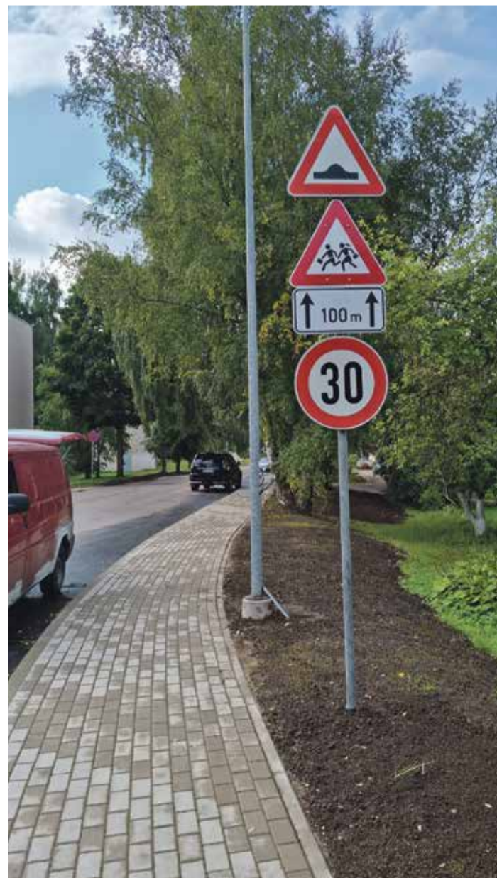
Izbūvēta gājēju ietve Skolas ielā, Saulkrastos.
