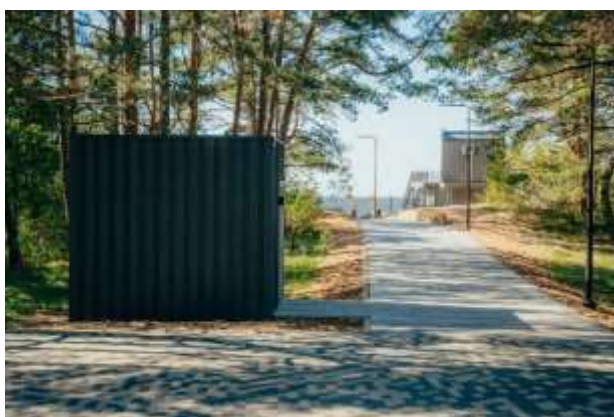
22. attēls. Projektā “Pludmales “Centrs” labiekārtošana” ieklāts bruģakmens segums Pludmales ielā un izbūvēta tualetes ēka
